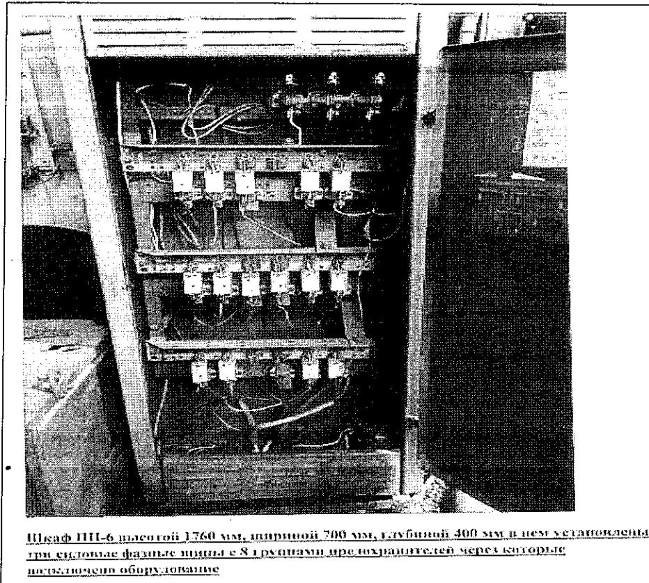
Согласно опросу электромеханика работа заключалась в следующем: отключение неиспользуемого распределительного пункта РП-3 (ПП-6 ГР6), демонтаж шкафа РП-3(ПП-6 ГР6), монтаж нового шкафа и его подключение к преобразовательному пункту ПП-6. В конце рабочей смены 17.03.2021 электромонтер устно доложил электромеханику о том, что все работы выполнены.
