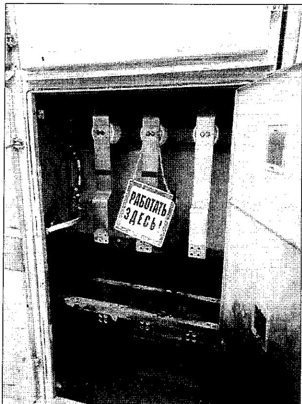
указано, что под напряжением остались Т1, Т2 и их присоединения КРУН 10 кВ, втычные контакты ячейки выключателя ВЛ-10 кВ № 01 со стороны сборных шин, соседние ячейки № 03 и №19.
