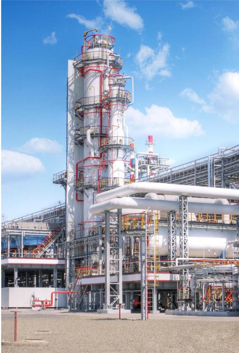
Строительство установки гидроочистки дизельного топлива по лицензионной технологии компании Axens мощностью 3000 тыс. тн/год (ввод – 2012 г.)
