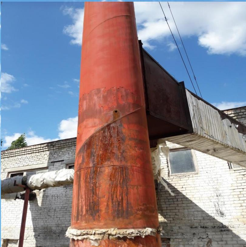
ООО «Волжские тепловые сети». Не проводится замена или техническое диагностирование специализированными организациями тепловых энергоустановок, отработавших расчетный ресурс.
