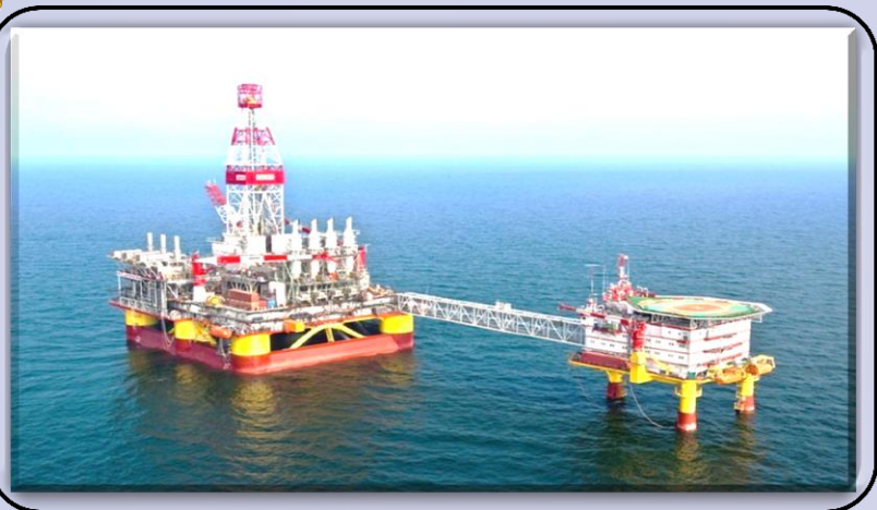
ООО «Лукойл- Нижеволжскнефть»
